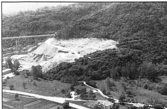
Cantiere località Braja: situazione attuale.
